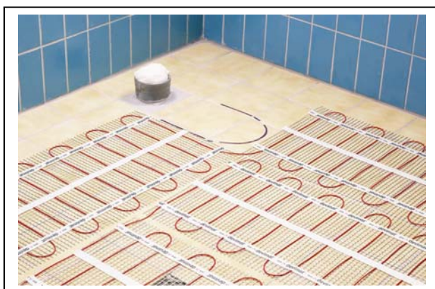
Рис. 4. Монтаж нагревательного мата devimat™ DSVF в ванной комнате на старую плитку.
